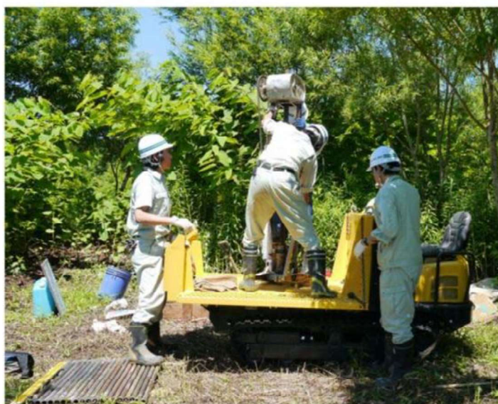
自走 オランダ式貫入試験機の使用
