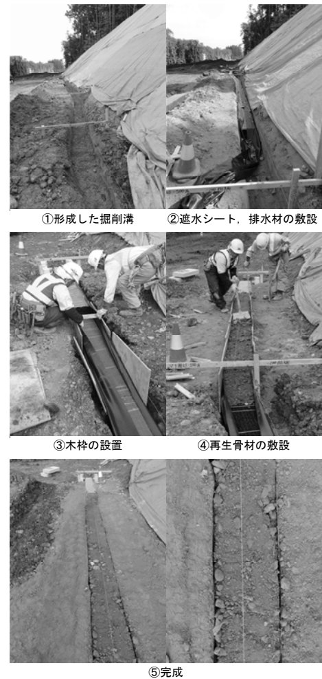
図-2 開発した小段排水溝の施工手順
