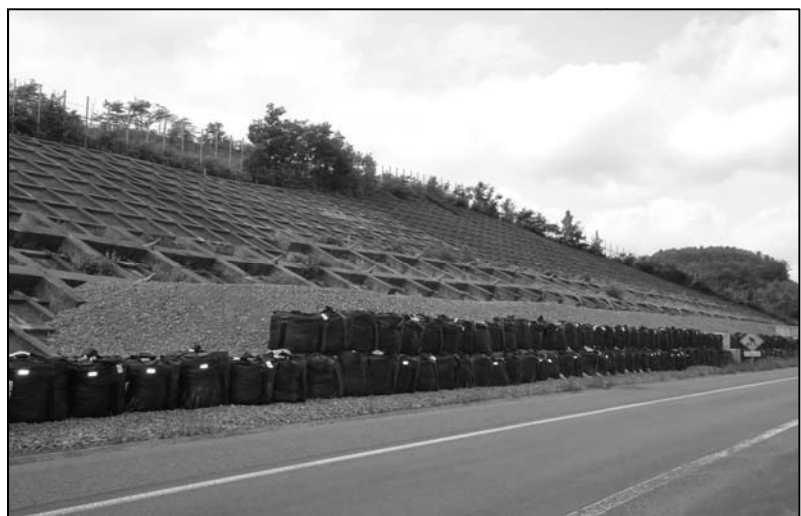
図-8 応急対策工完了写真
