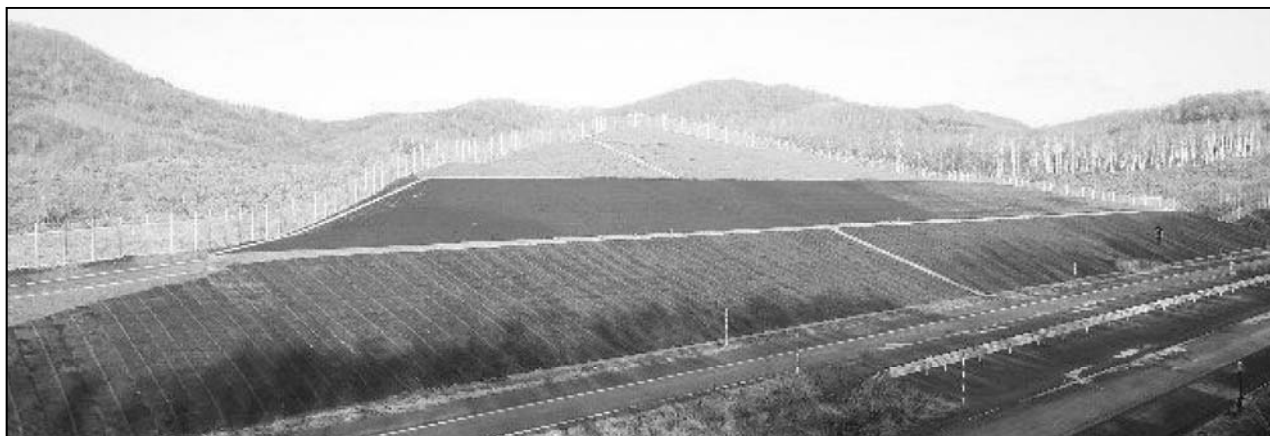
図－13 工事完成状況
