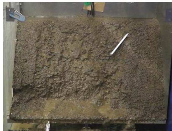
写真-3 のり先部の崩壊状況 (正面)
