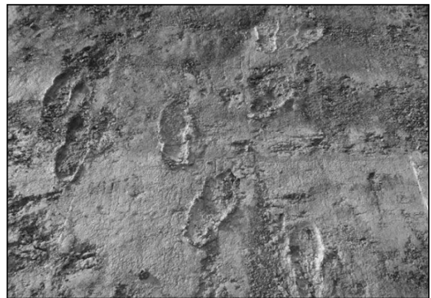
図-12 1段目のり面掘削状況
