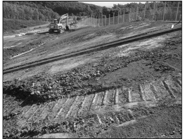
図-11 2段目のり面掘削状況
