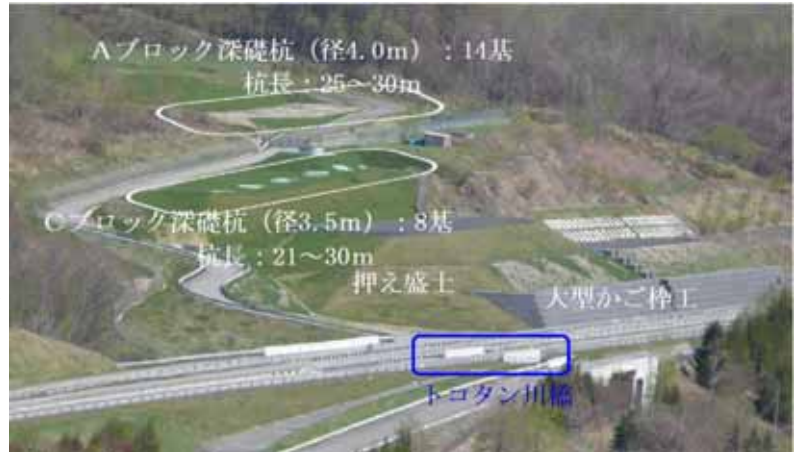
図-14 本対策完了後後の全景
