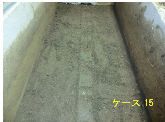
図-11 引抜き試験後のストリップ設置面の状態
