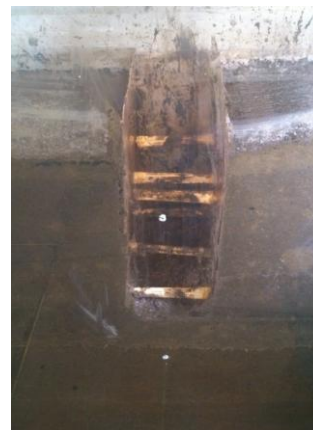
写真-2 模型地盤の掘削後の様子
