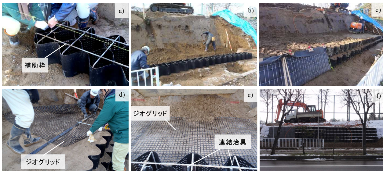
写真1 補強土壁の施工過程
