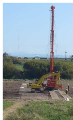
写真2 ドレーン打設状況
