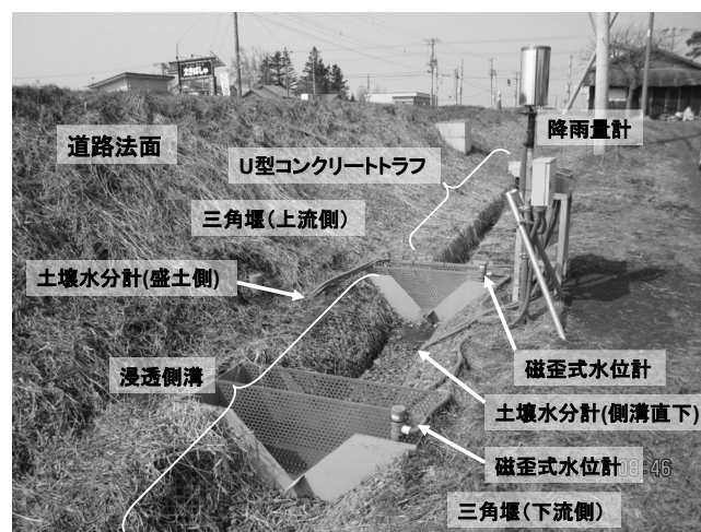
写真-3 現場浸透率試験装置の設置状況
