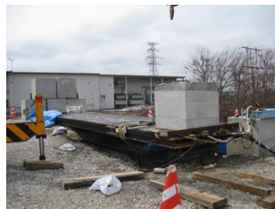
図-11 舗装された鋼桁
