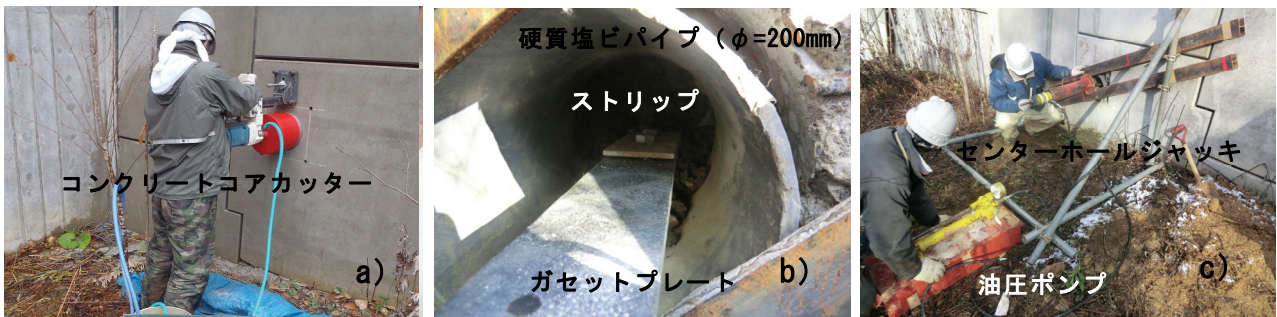
図-5 現場引抜き試験前の作業内容
