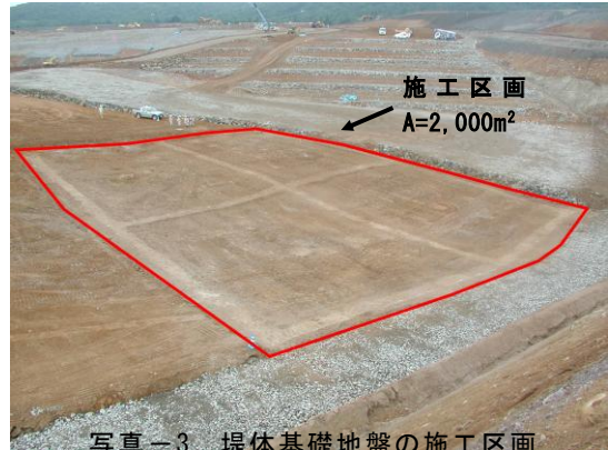
写真-3 堤体基礎地盤の施工区画
