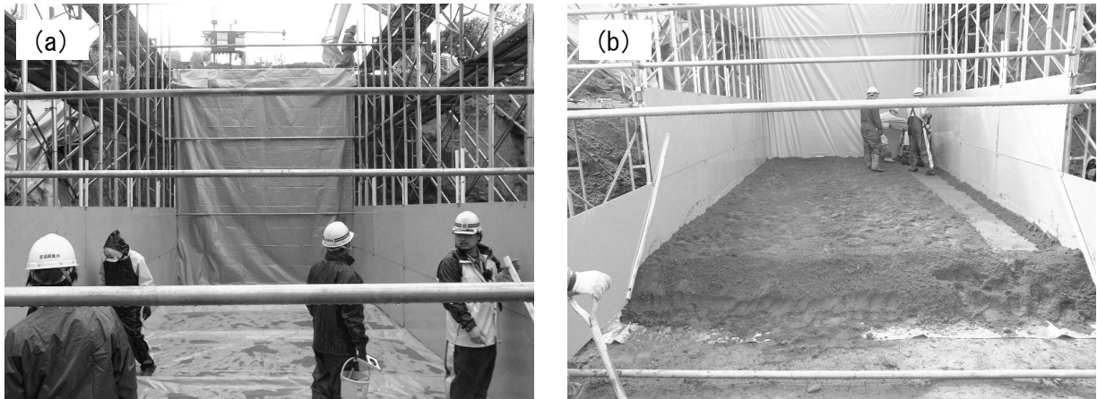
写真-2 盛土構築の状況：(a) 水平基盤面と側方拘束工の構築，(b) 盛土 1 層目の締固め状況
