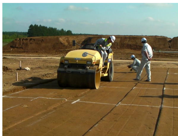
写真-2 盛立試験時の状況(4t級振動ローラー)
