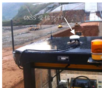
写真-6 GNSS受信アンテナ設置状況
