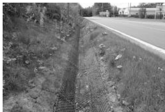
写真-2 浸透側溝の設置状況
