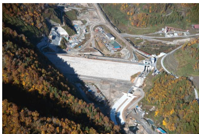
写真-11 京極ダム空撮写真（H24.10撮影）
