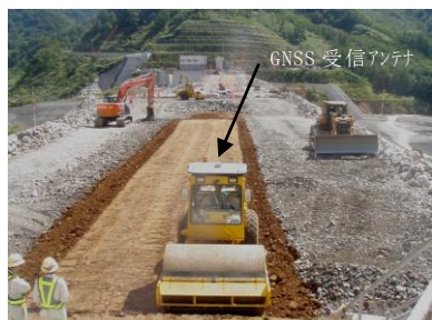
写真-5 転圧状況
