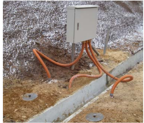
写真-3 計器設置状況
