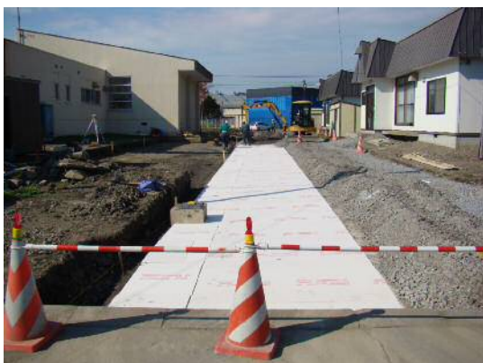
写真 4-1 断熱材の施工
