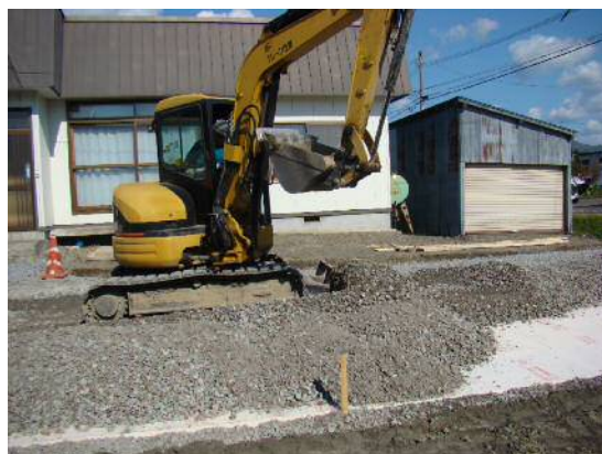
写真 4-2 路盤の施工
