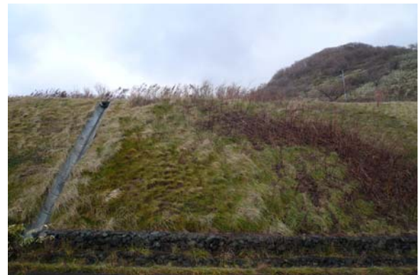
写真-1 計測斜面状況 (汐吹)
