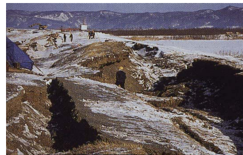
写真－2 1993年の釧路沖地震における河川堤防（十勝川統内築堤）の被災状況 2)
