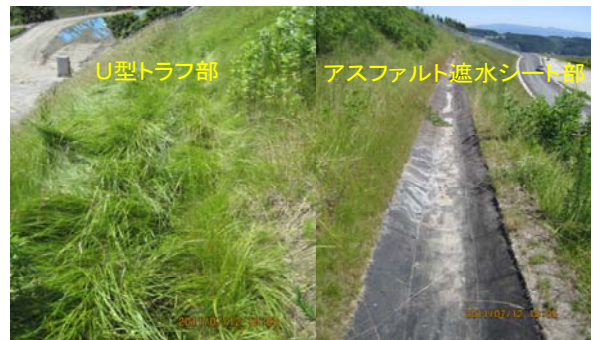
写真-4 小段排水溝の防草効果
