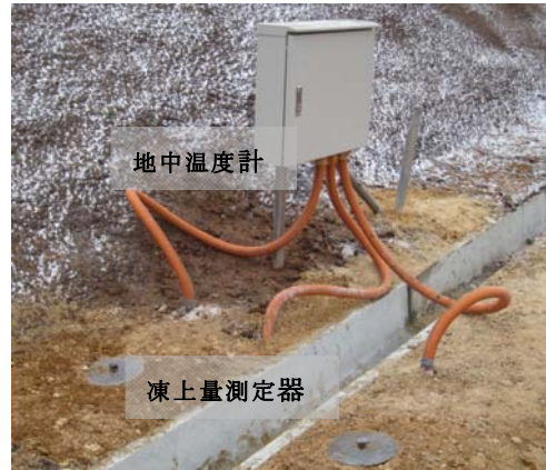
写真-3 計器設置
