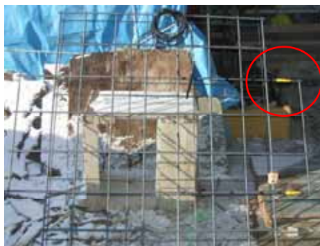
写真-3 応力測定位置(袖部背面側鉄筋)
