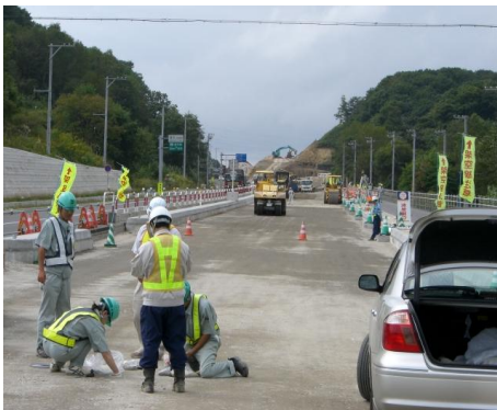
写真 - 4 虎杖浜工事現場 下層路盤 (切込碎石 C-40)
