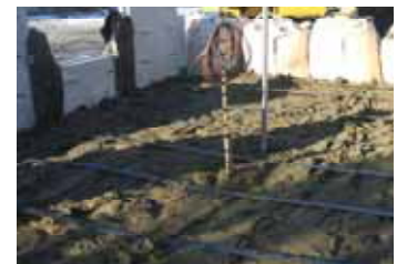
写真-2 盛土施工状況
