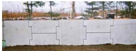
写真-1 施工完了状況(A壁西向き)
