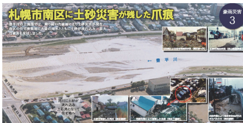
写真-4.2 豊平川周辺で発生した地盤災害の状況 4)
