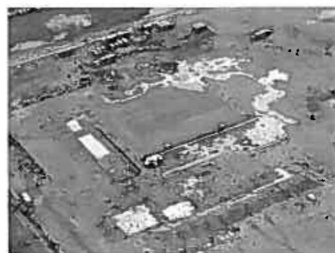
写真-3 発破後の液状化の状況 (北海道開発局ヘリより撮影)
