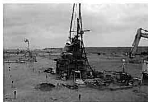
写真-2 調査状況
