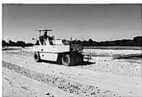
写真-2 10t タイヤローラーの転圧状況
