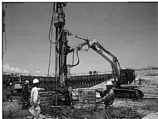
写真-3 橋台基礎周辺の地盤改良の状況
