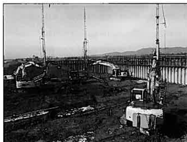
写真-4 改良機3台投入状況
