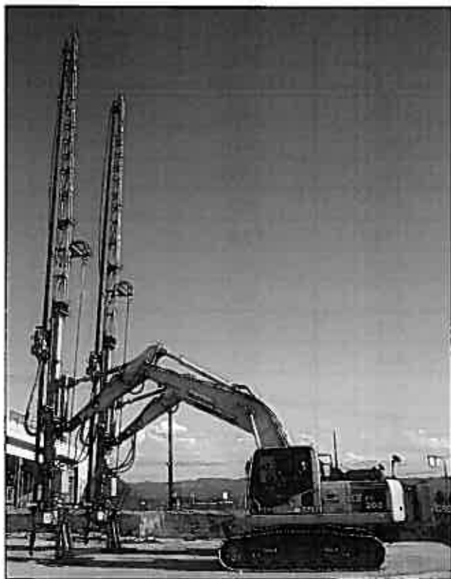
写真-1 MITS 工法の施工機 (2 台)
