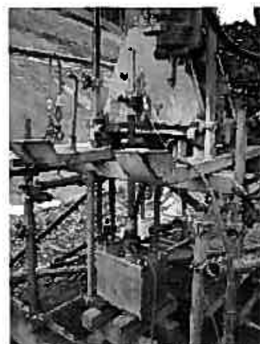
写真-2 測定機器設置状況
