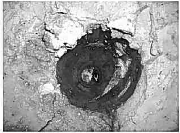
写真-3 試験後の孔壁の状態 (原位置せん断摩擦試験)
