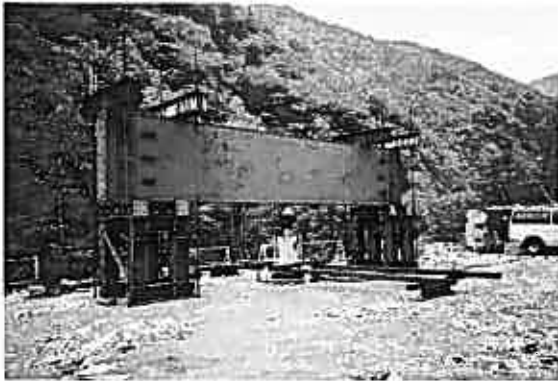
写真-1 載荷試験実施状況（鉛直載荷）
