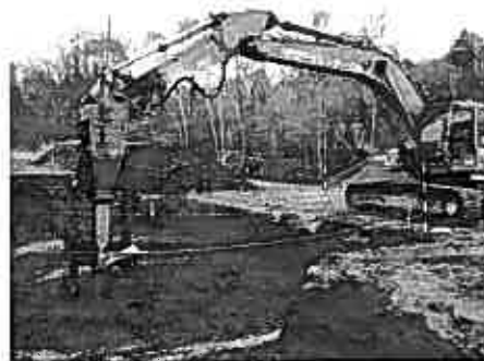
写真-1 トレンチャー式攪拌工法
