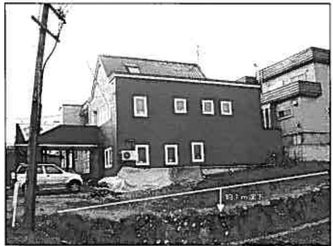
写真-1 家屋の基礎地盤の沈下
