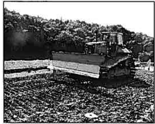
写真2 破砕走行状況
