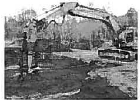
写真-1 トレンチャー式攪拌工法
