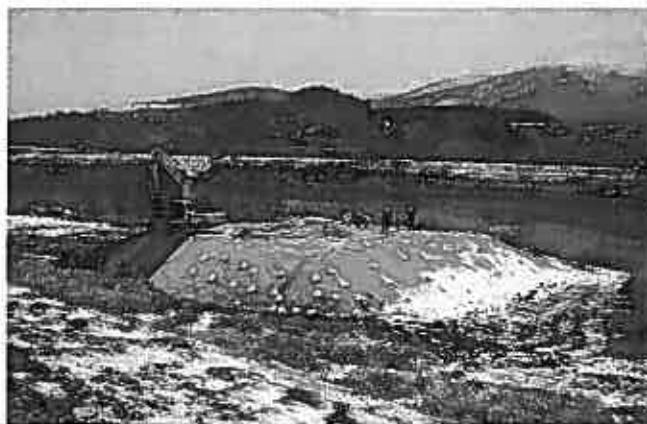
写真-4 置土期間中における養生（雪混入防止）
