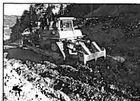
写真4 切土部の掘削および破碎走行
