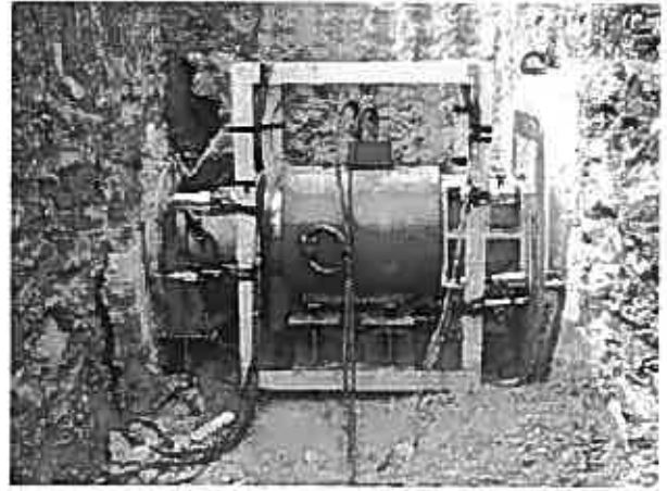
写真-2 載荷試験状況（水平載荷）
