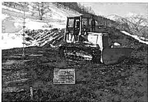
写真-5 築堤盛土状況（25cm 敷均し）
