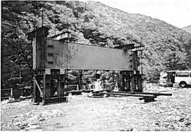
写真-1 載荷試験実施状況（鉛直載荷）
