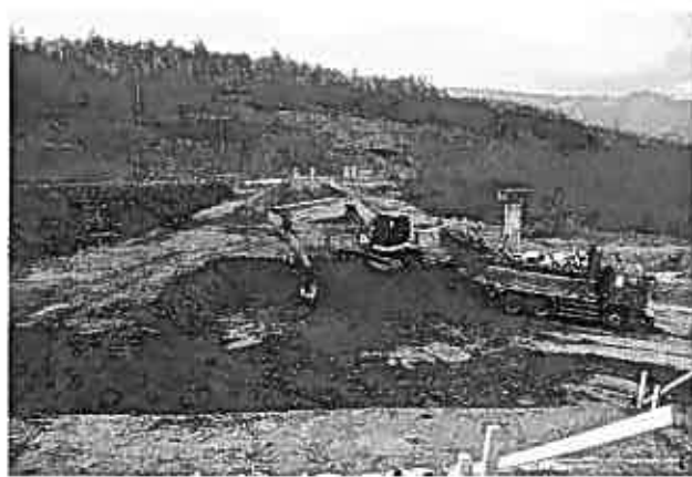
写真-6 築堤開削状況（層状掘削）
