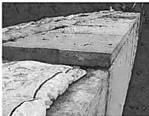
a) コンクリートブロックの設置
