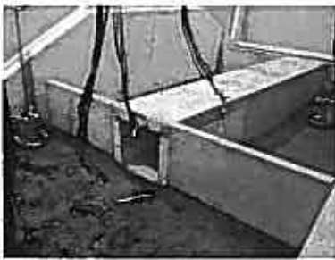
写真-1 C-Box 設置
