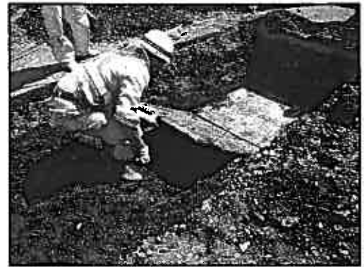
写真-2 試験ヤード開削（断熱材の掘り起こし）
