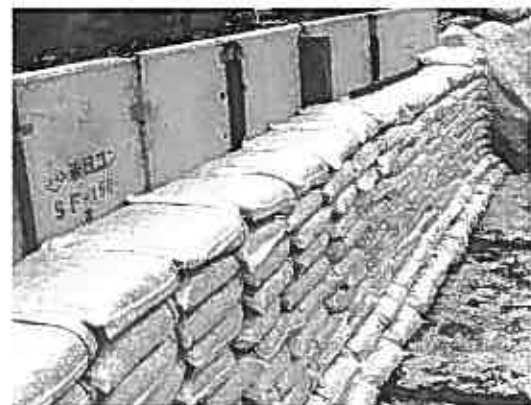
b) 土のうの積み上げ
