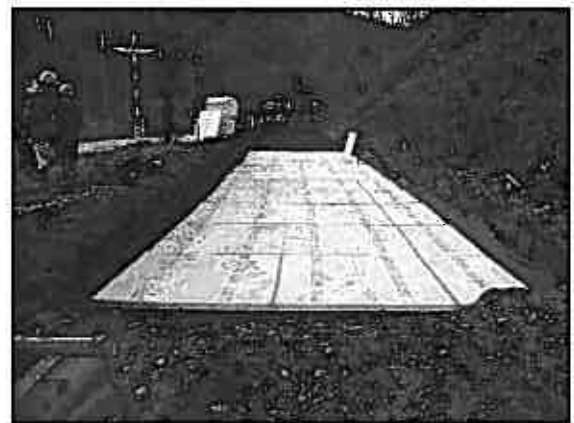
写真-1 断熱材敷設状況 (穂別地区試験施工)
