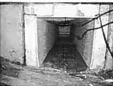
写真-4 断熱材付設状況
