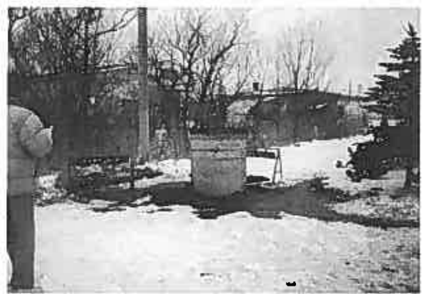
写真-9 2003年十勝沖地震におけるマンホールの突出(左)と1993年釧路沖地震におけるマンホールの突出(右)
