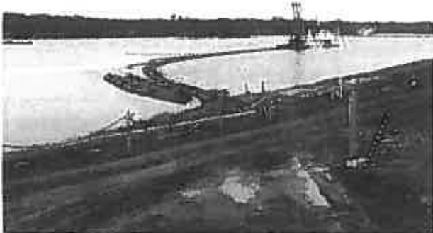
写真-1 浚渫状況
