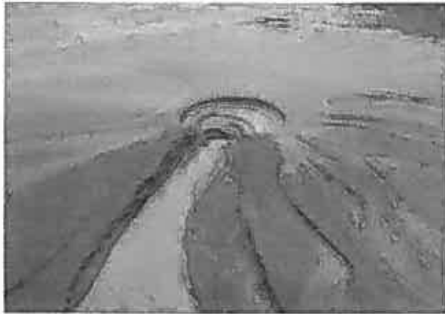
図-11 苫小牧市東港 中央道路における噴砂 (室工大 木幡助教授 提供)
