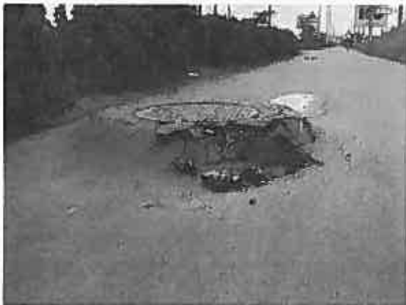
写真-9 2003年十勝沖地震におけるマンホールの突出(左)と1993年釧路沖地震におけるマンホールの突出(右)
