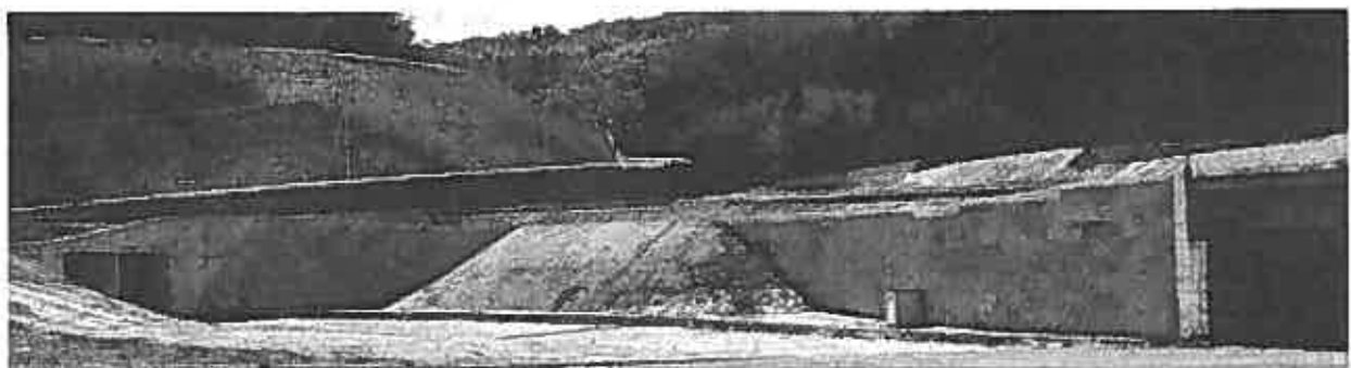
写真-8 完成状況
