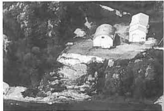
図4 南東上空からみた北見市広郷南5線西14号でのスランプ状崩壊（農業施設裏の崖は切土法面）
