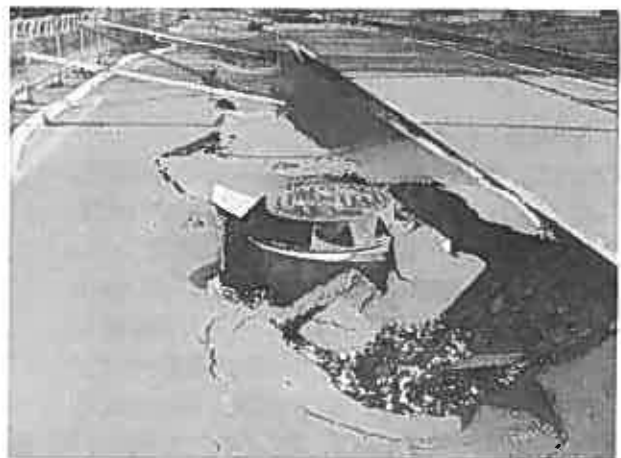
写真-13 北海道東方沖地震で対策を実施した区間（阿寒町） 写真-14 阿寒町役場近傍の下水道管理設道路の陥没
