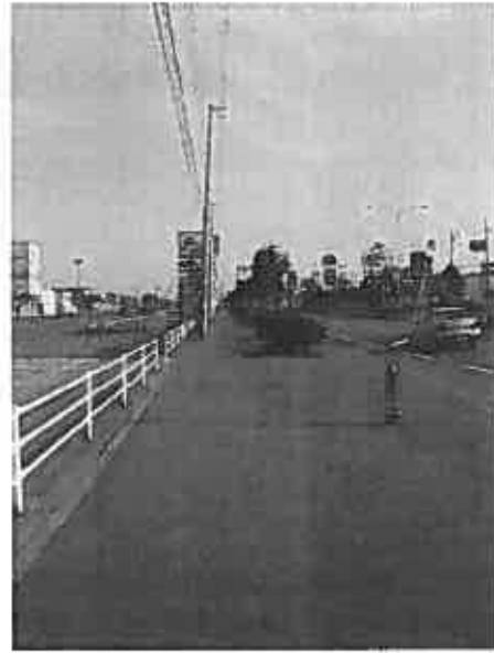
2003年十勝沖地震 マンホールの浮き上がり無し
