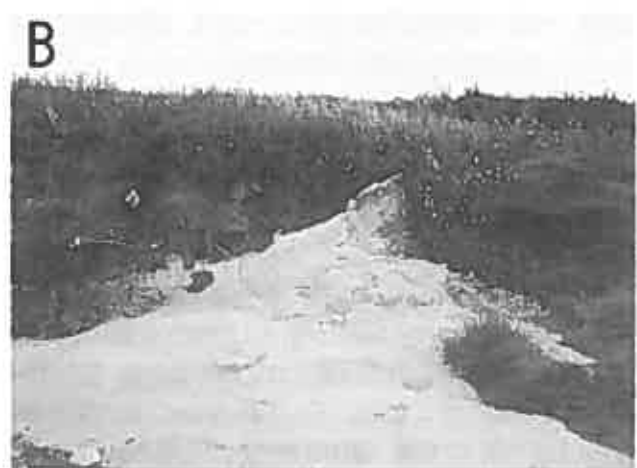
図4 南東上空からみた北見市広郷南5線西14号でのスランプ状崩壊（農業施設裏の崖は切土法面）
