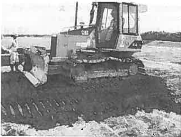
写真-9 トラフィカビリティの直接確認
