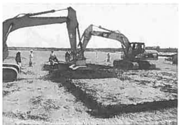
写真-8 現地試験例-2 (1 材料搬入)
