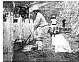
写真-5 改良土の転圧状況
