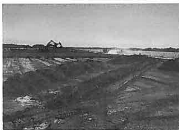
写真-14 トレンチ排水処理
