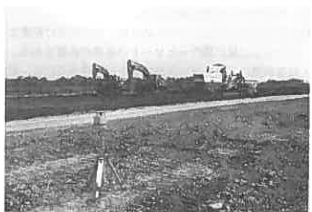
写真-12 本施工状況
