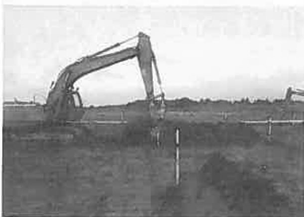
写真-7 現地試験例-1 (2 材料搬入)
