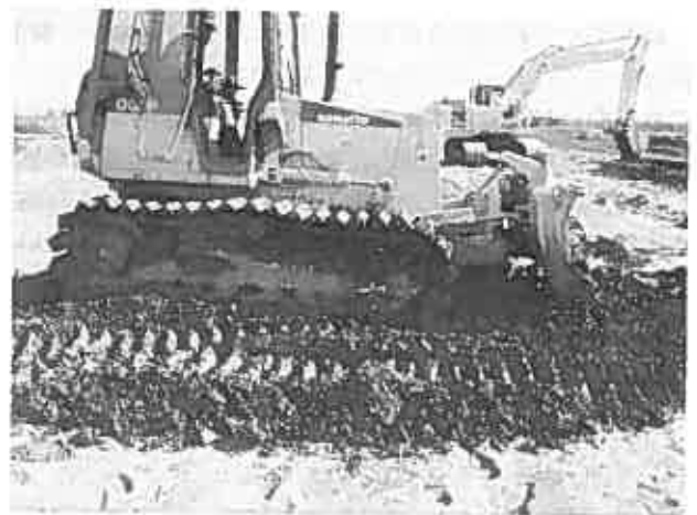
写真-10 敷き均し困難な場合
