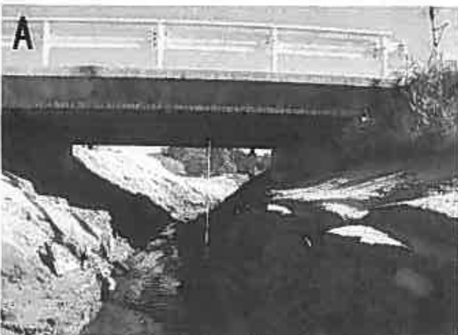
図9 ポンチャシコツマナイ川を埋めた液状化火山灰 (河道内は排土されている)
