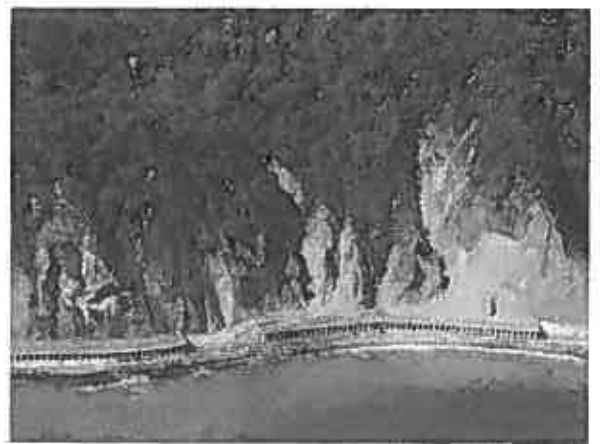
図-10 国道 336 号線 黄金道路斜面の土砂崩落
