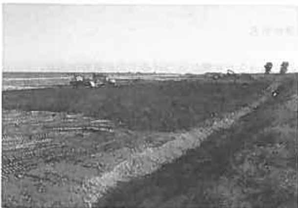
写真-11 本施工ヤード全景
