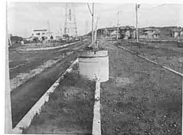
写真-12 東側で最も突出したマンホールと噴砂(同上)と傾斜した電柱(東陽団地)
