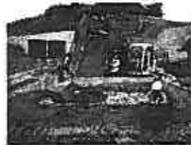
写真-3 バックホリによる改良土の攪拌混合状況
