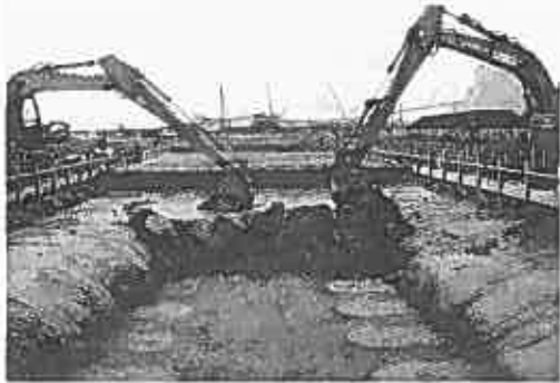
写真-1 道床基礎の施工状況
