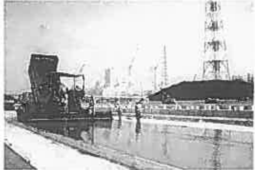
写真-2 貯炭場の施工状況
