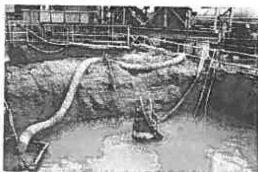
写真-6 攪拌ポンプ設置状況
