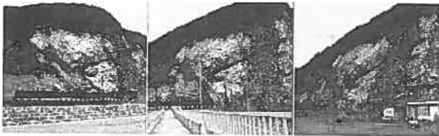
写真-1 異なる方向からの急崖写真
