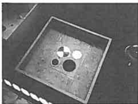
土圧計設置時
