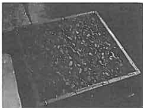
材料 E (礫) 撤き出し終了時
