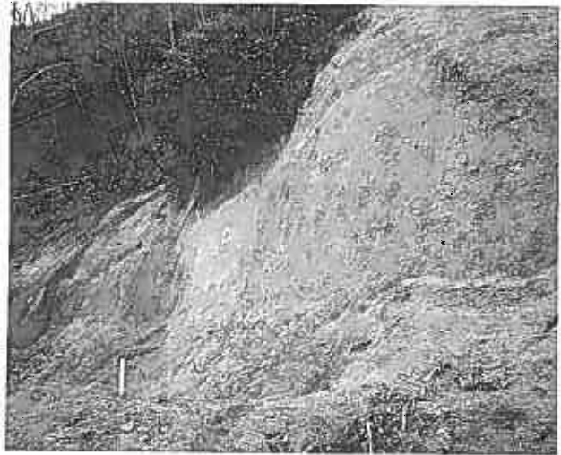
写真-5 地点fの現場の様子
