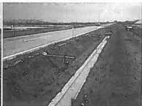
写真-3 野外実験の施工後
