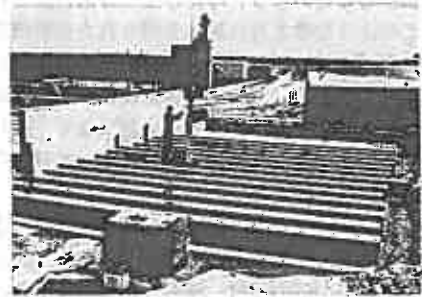
写真-2 载荷実験状況
