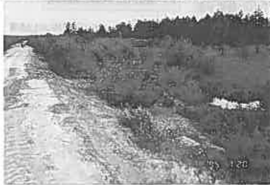
写真-5 初チェルシ近郊の 道路盛土の崩壊例
