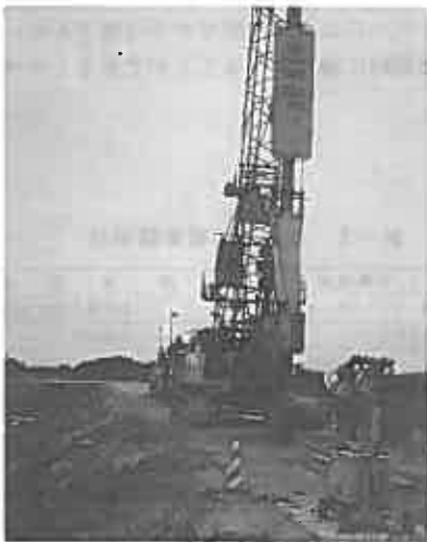
写真-2 遮水壁工事施工状況
