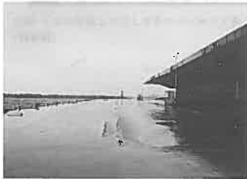
写真-1 東港漁業埠頭南側岸壁ケーソン部
