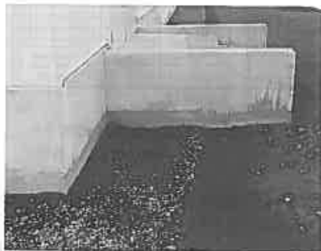
写真-7 建物外周に残った泥水の跡(ツルハースポーツセンター)
