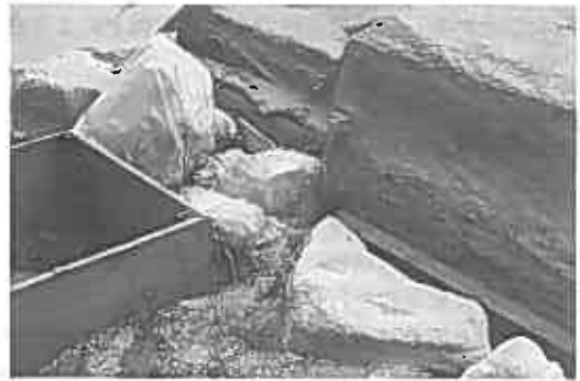
写真-1 暴露状況
