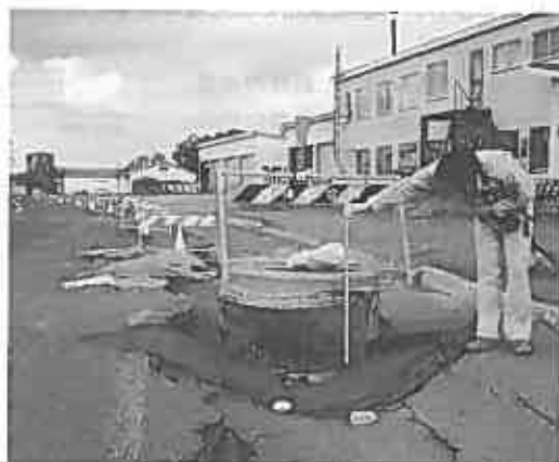
図-3 海岸部と内陸部の地質断面図 写真-3 下水道マンホールの浮き上がりと路面の沈下・陥没 (標津町)
