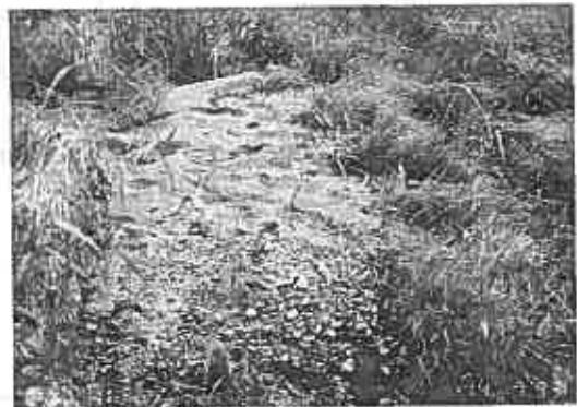
写真-4 砂とともに小礫を噴き出した噴砂
