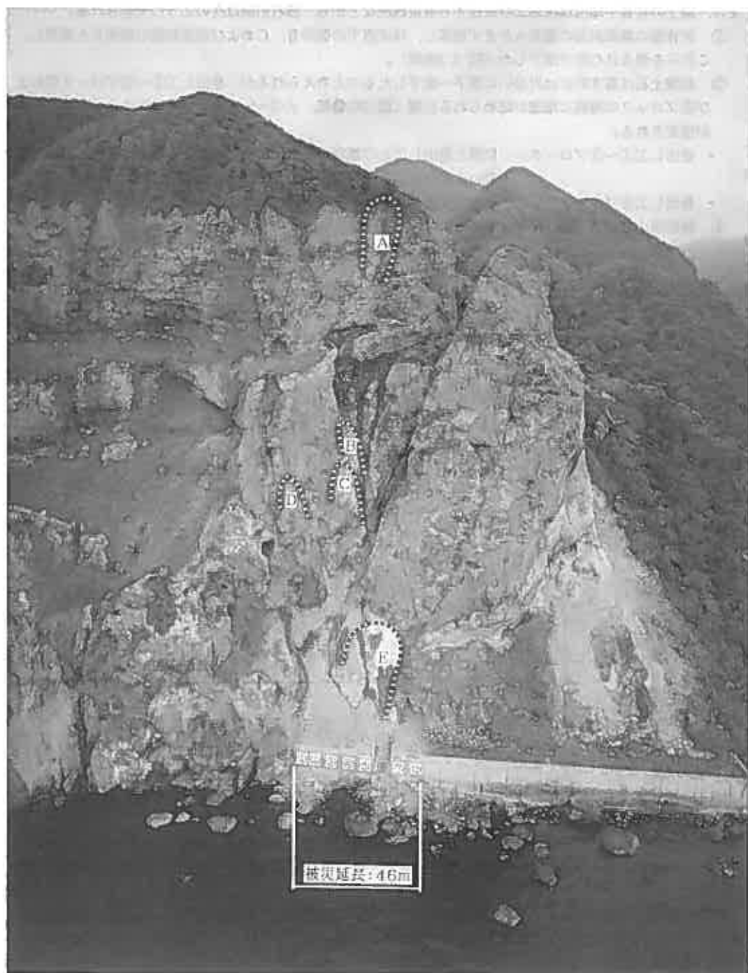
写真-1 崩壊斜面および被災箇所全景写真
