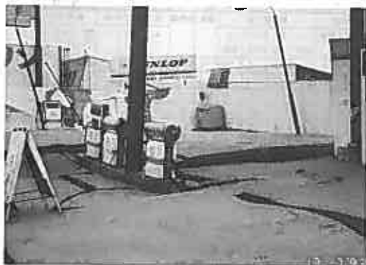
写真-1 液状化に伴う地盤変状により被害を受けたガソリンスタンド
