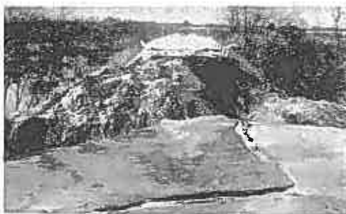
写真-5 被災パターン V型 一般道道大成西春別線 （路体全壊，盛土流出）
