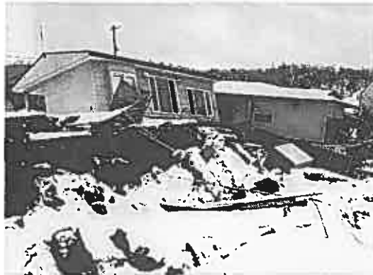
写真-1 住宅の損壊状況(1)
