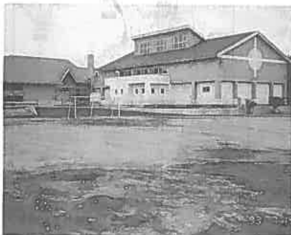
写真-3 長万部中の沢小学校の全景 (砂鉄採取跡の埋め戻し地盤の液状化 により左の校舎周辺の高い部分が低い 校庭に向かって水平移動した。)
