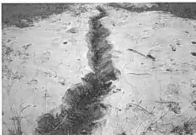
写真-1 北海道南西沖地震後噴砂状況
