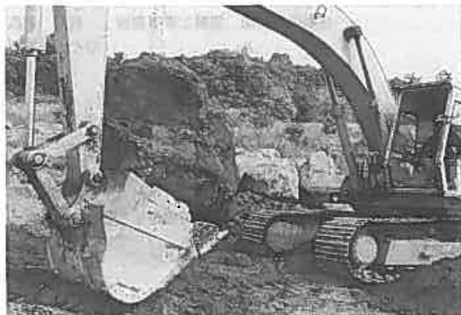
写真-2 掘削状況
