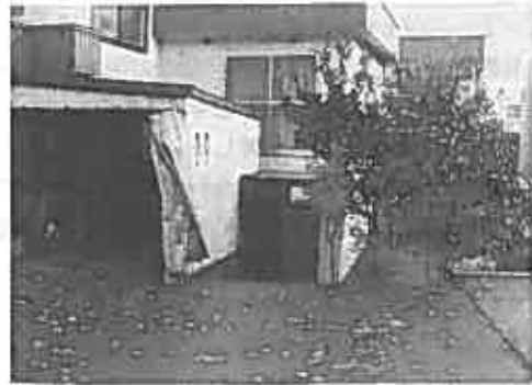
写真-5 家屋の沈下
