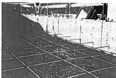
写真-1 補強土の概要
