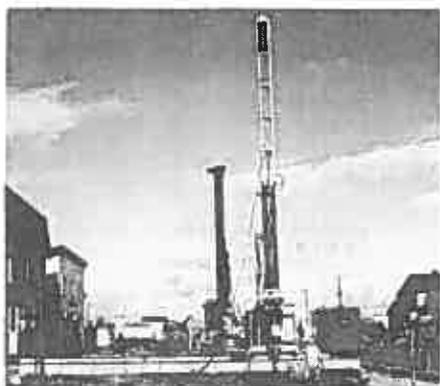
写真① 深層混合処理工法打設状況
