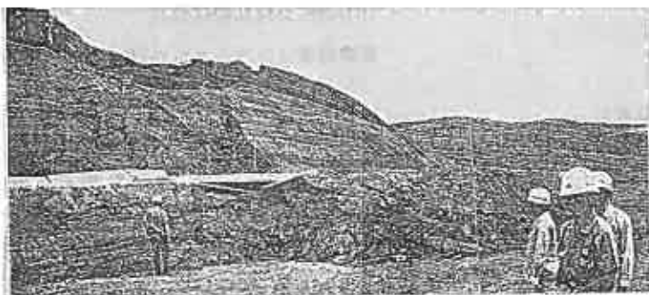
写真-1 1次崩壊状況
