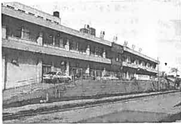
写真1 D棟南面 '79.3.12 中央部除去前 中央のシートに覆われている部分のスラブや梁が破断し、柱が破壊した。
