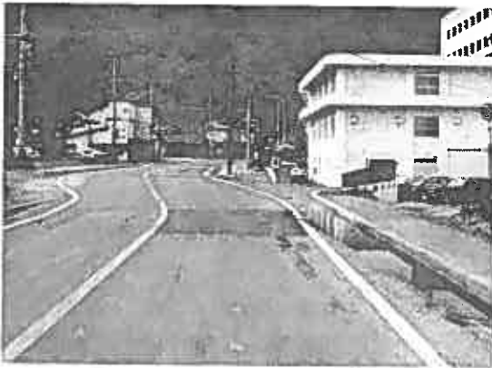
写真4 同上 '80.7.18 噴火後1077日 ずれの幅3,665 mm '81.10.15現在1531日 " " 4,275 mm 右側の建物は、D棟の35の両側1/3を修理改装したもの。
