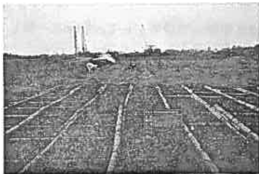
竹枠ネット敷設状況
