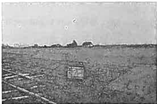
サンド・マット施工状況
