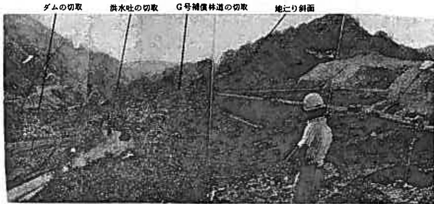
写真-1 洪水吐切取状況（呑口より下流を望む）
