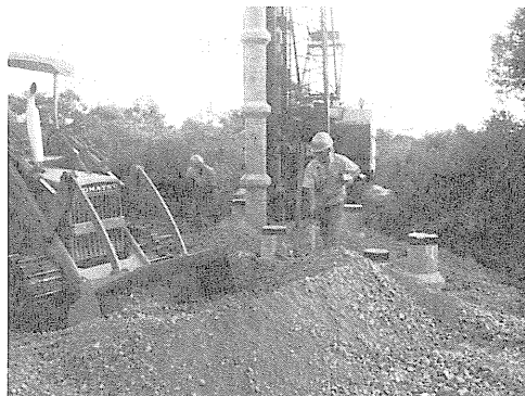
節付杭の打設状況
