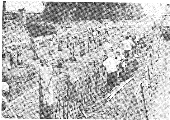
写真-1 施工状況
