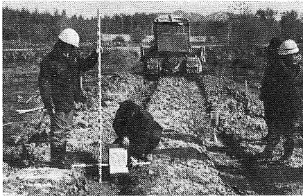
写真—1 現場トラフィカビリティー試験状況
