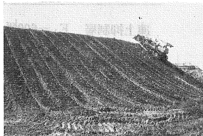
写真一7 法面の転圧状況
