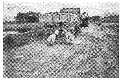
写真-3 走行試験状況
