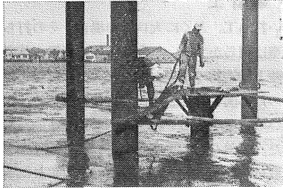
写真—2 導材ぐいの設置
