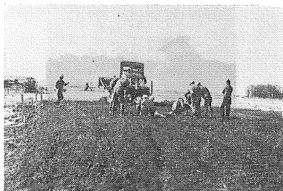
写真-2 転圧試験状況
