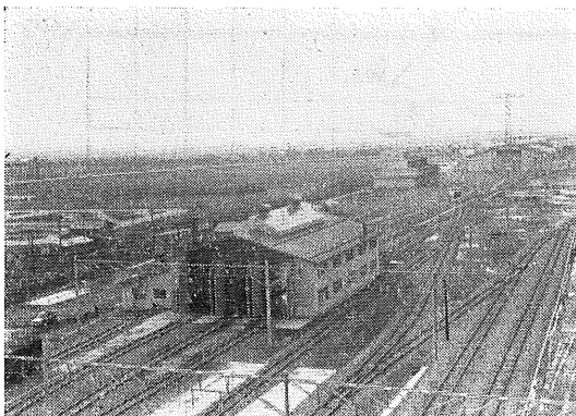
写真-2 岩見沢車両基地新設全景 (撮影 43年 10月)
