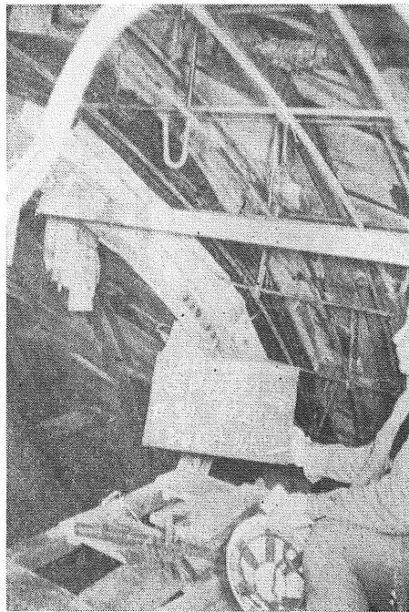
写真二 縦継目用止水板
