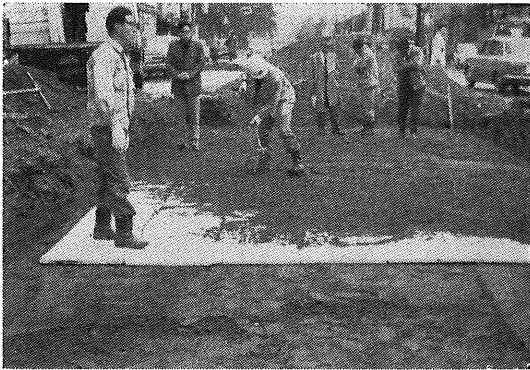
写真一 断熱材工法の凍上防止試験
