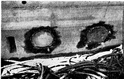
写真一5 土圧計(右)との間隙水圧計(左)の取付
