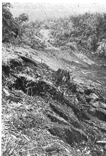
写真二 切土法勾配 1 割のときの崩壊状況 (北方より写す)
