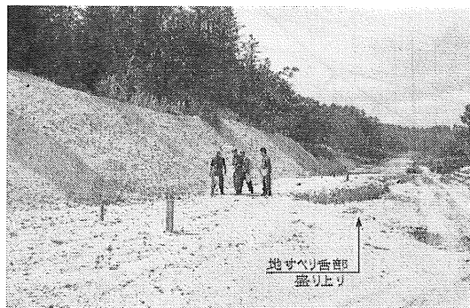
写真—4 地すべり後に於ける舌部の盛り上り状況
