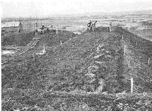
写-1 試験堤の築造
