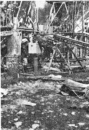
写-8 イコス壁コンクリート施工
